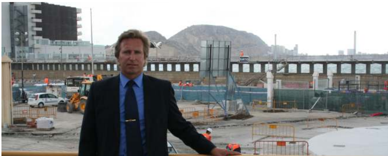
► Campos muestra a sus espaldas las obras del puerto de salida de la VOR
